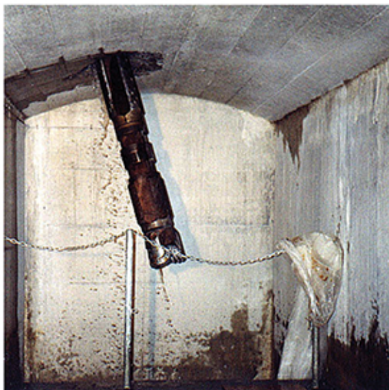
Obr.3 Pronik cílového vrtu
