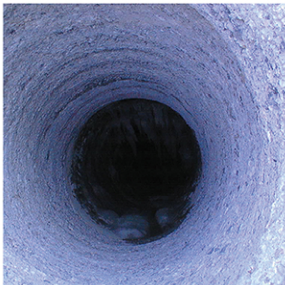
Obr.11 Nástřik betonové směsí ve vrtu
