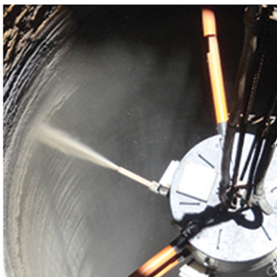
Obr.13 VPV po nástřiku betonové směsí
