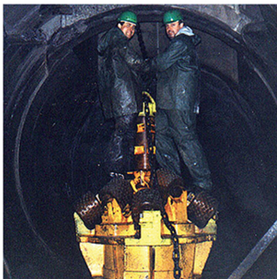
Obr.7 Zahájení rozšiřování vrtu
