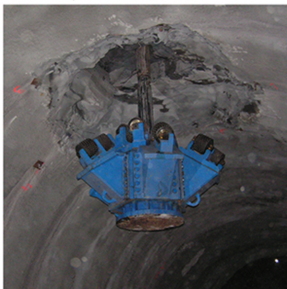
Obr.7 Zahájení rozšiřování vrtu
